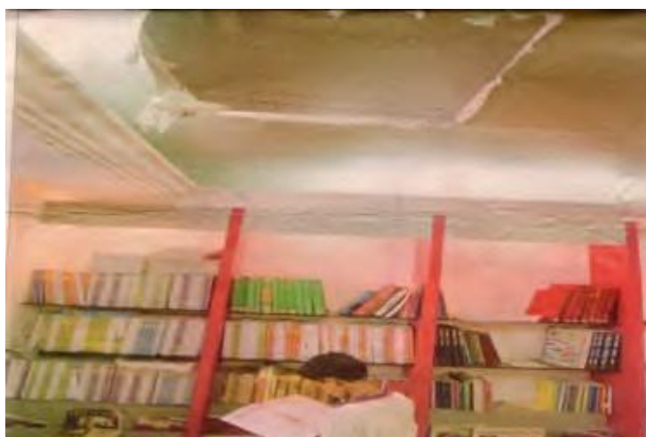
Figura 4 – Teto da escola da Rua do Hospício
