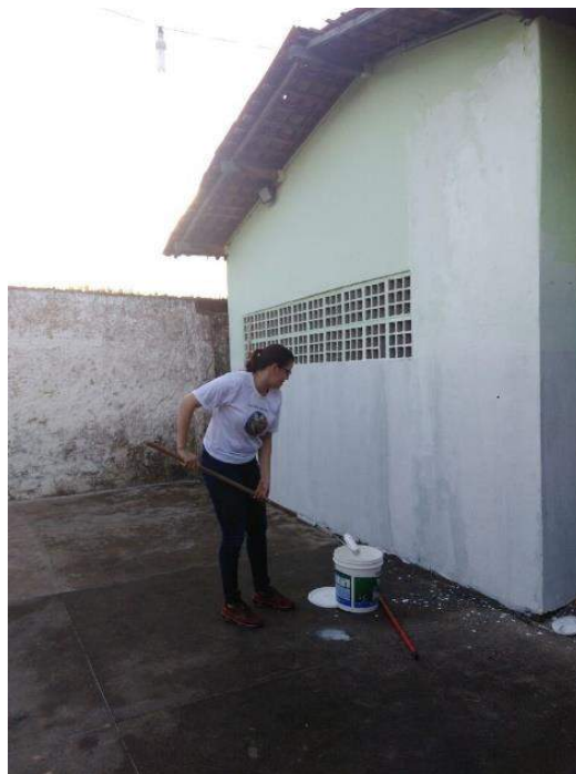
Fotografia 2- Pintura do espaço físico
